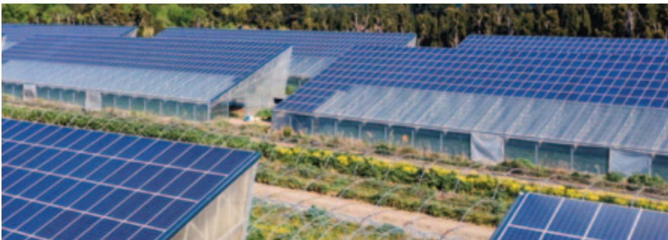
Slika 21 AFV sistem na rastlinjaku z nasadom jagod [1]
